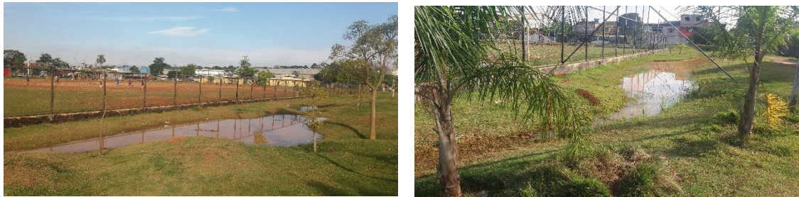
Fig. 2 — Fotos da vala de infiltração (úmida
