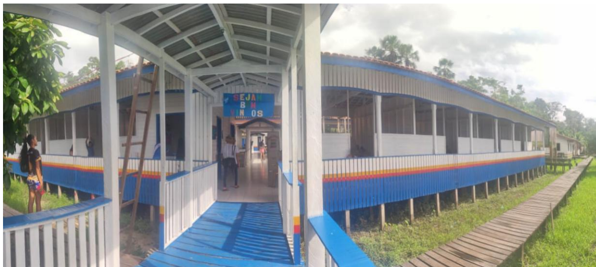
Figura 1– Escola Municipal de Ensino Fundamental Gomes Netto
