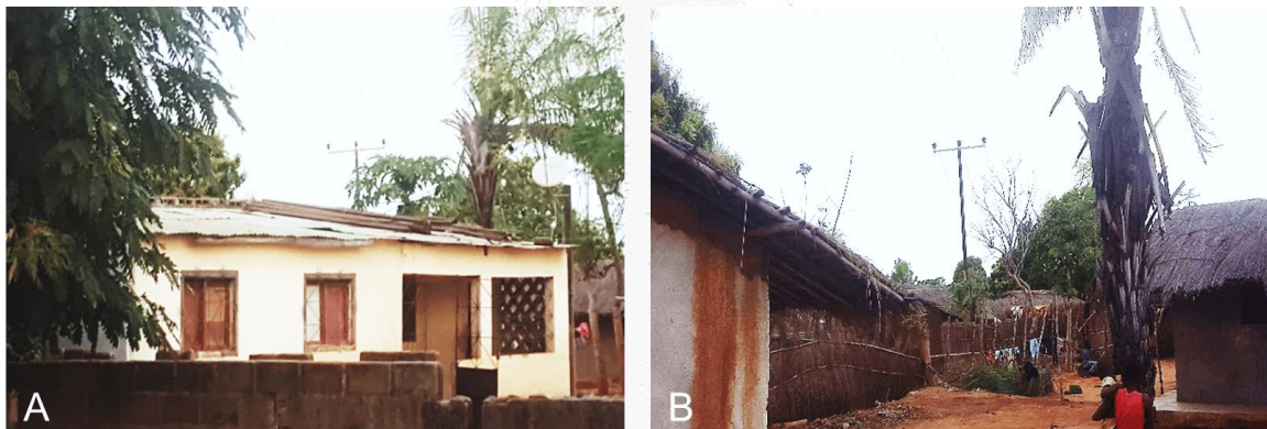
Figura 2. Habitações erguidas a distância menor do que a recomendada por lei: (A) casa de construção convencional no bairro Namihiro ; (B) casa de construção precária no bairro Nacopo .
