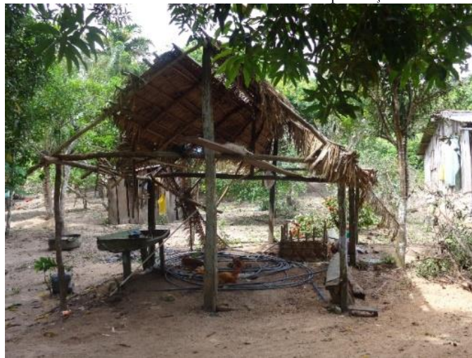
Figura 03 – Casa de Farinha em Santarenzinho: construção feita de madeira e palha que abriga o forno e outros instrumentos e materiais utilizados na produção de farinha.
