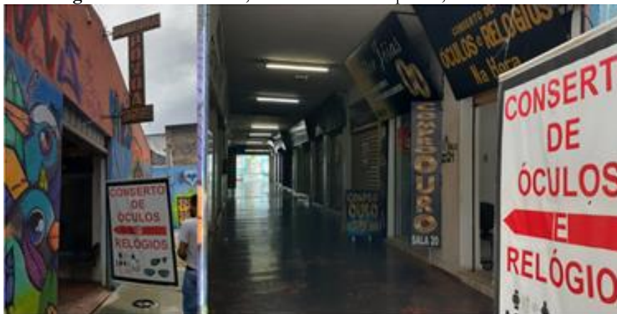
Figura 5 – Galeria Póvoa, entre o beco dos esportes, na Rua do Lazer
