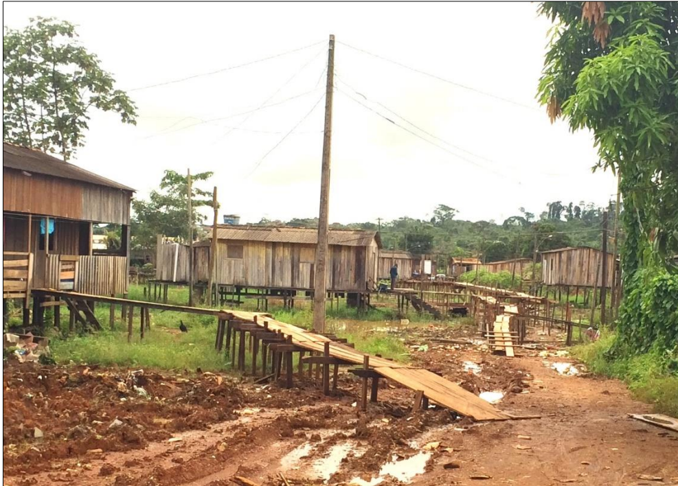
Figura 1 – Padrão construtivo de algumas residências da área afetada (ADA)
