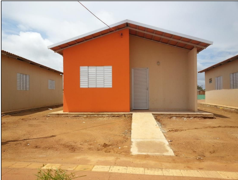
Figura 2 – Perfil de uma casa do RUC recém construída, em 2015
