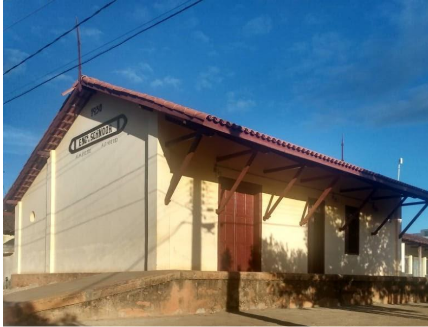
Figura 5 – Estação Ferroviária de Engenheiro Schnoor
