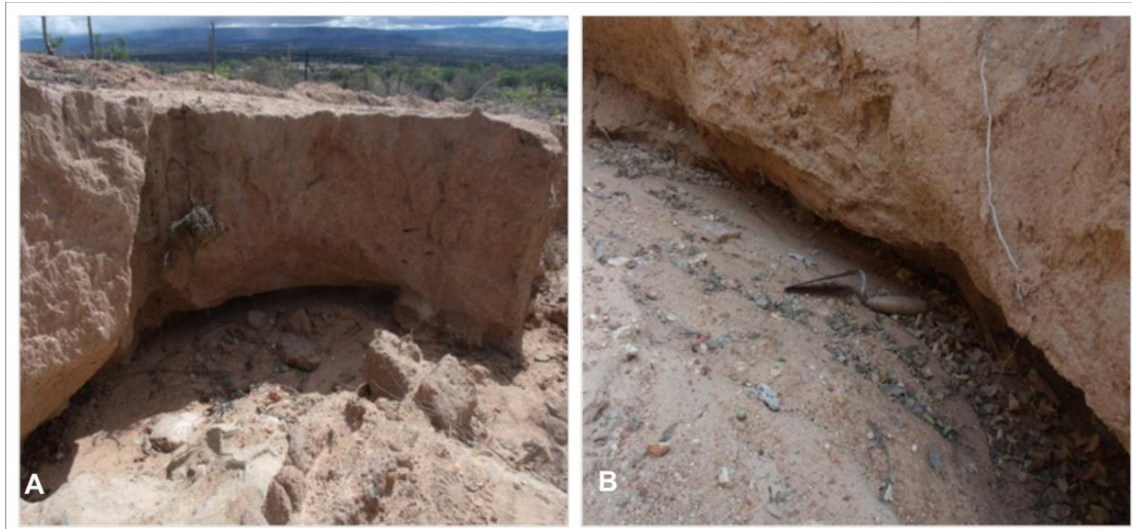
Figura 07 – A: Processo evolutivo de voçoroca a partir do escoamento subsuperficial. B: Microcanais formados no interior da voçoroca por efeito do escoamento subsuperficial. Foto: Leandro Pereira, 2012.
