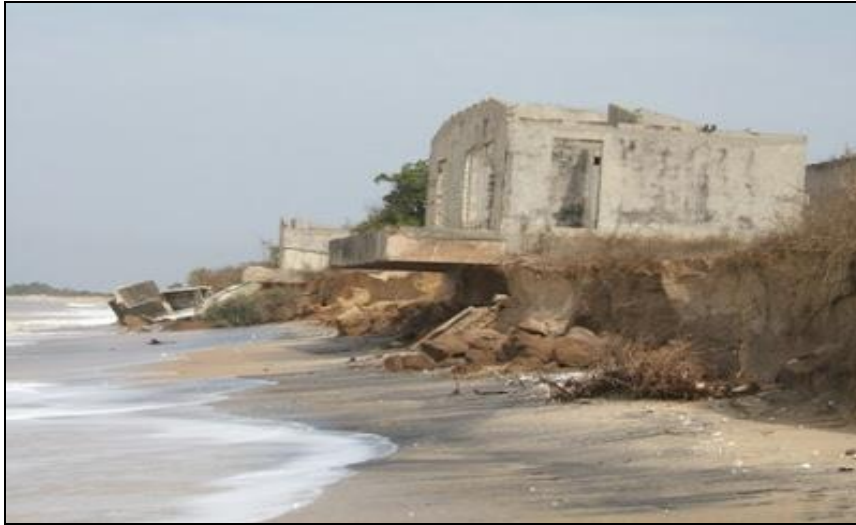
Figura 03 – Erosão costeira na praia de Varela no município de Cacheu Fonte: Mistério do Turismo de Guiné-Bissau, 2012.
