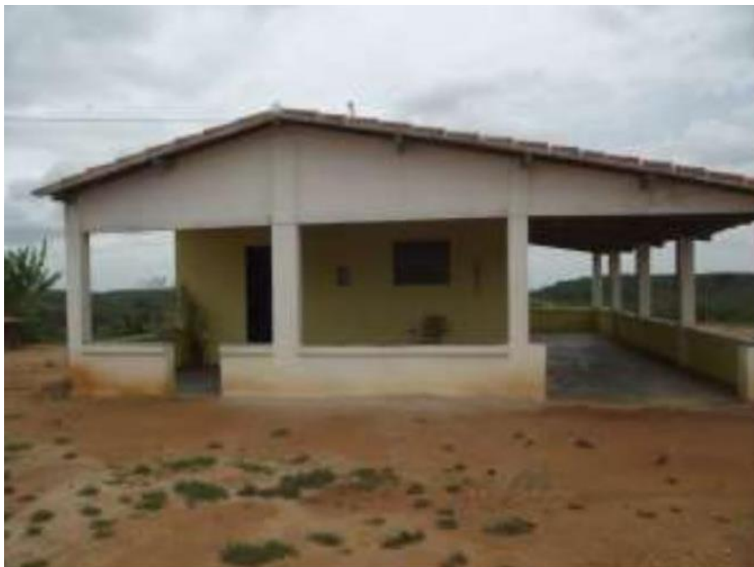
Figura 17. Casa de Sebastião Guedes.
