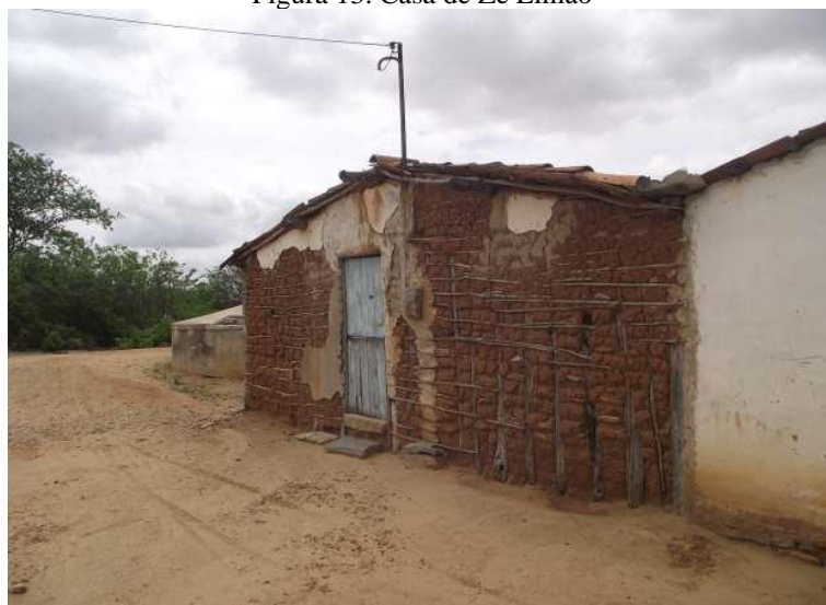
Figura 14. Casa de alvenaria com Extensão em taipa. Armazém.-depósito
