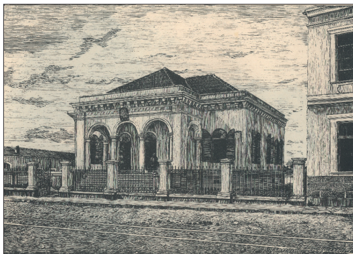
Figura 2 - Fachada da Escola Oliveira Bello
