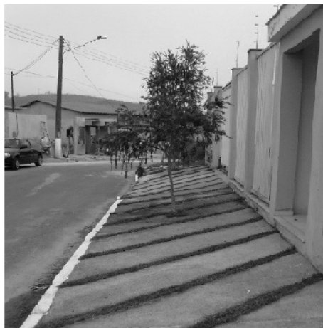
Foto 2 - Espécie exótica e plantio inadequado
