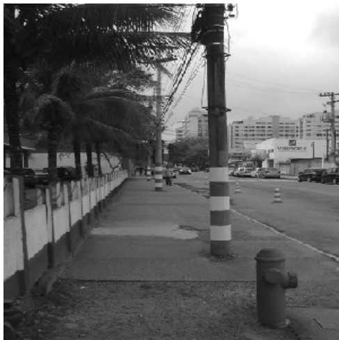
Foto 4 - Piso irregular /obstáculos na calçada
