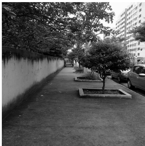
Foto 5 - Tamanho inadequado de canteiro
