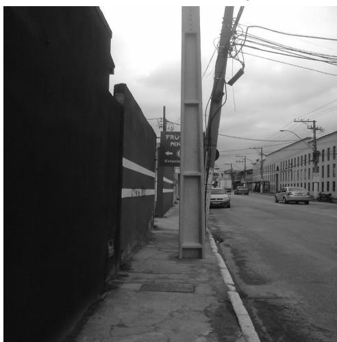
Foto 6 - Poste em local inadequado
