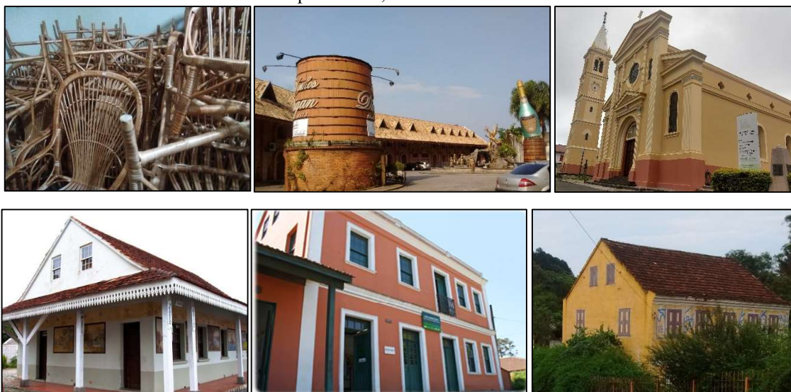
Foto 2 - Produtos em Vime; Vinícola Durigam; Igreja Matriz de São José; Casa das Pinturas – ACISF; Casa Culpí – CRAS, Casa dos Gerânios
